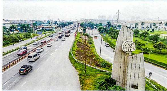
Hình 4.6. Cầu Thăng Long
